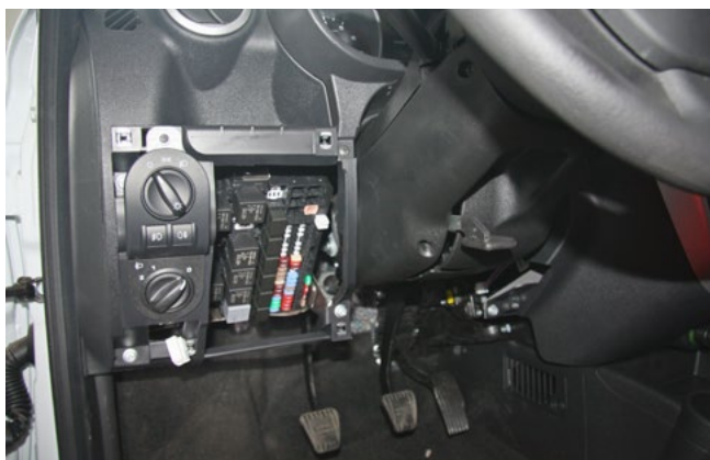
Фото 1.3. Пластиковая накладка снята
