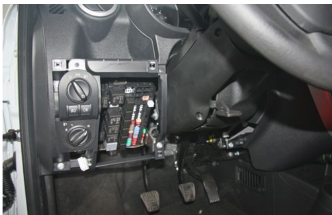
Фото 1.3. Пластиковая накладка снята
