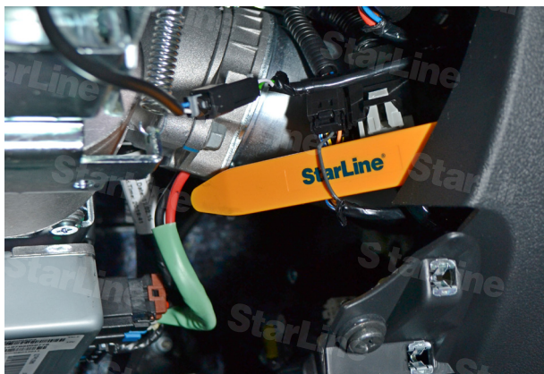
Фото 13. Контроль работы двигателя (серый)
